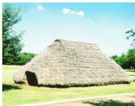
▲竪穴住居外観 (第2号住居跡)
