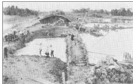
富士見市史 通史編下巻 ↑図 66 明治 43 年荒川堤防の復旧工事
