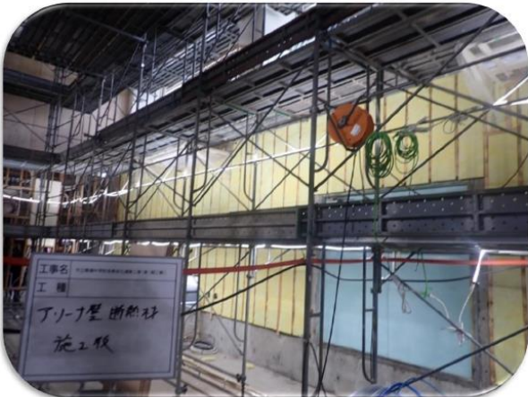
改修実施中 断熱材施工
