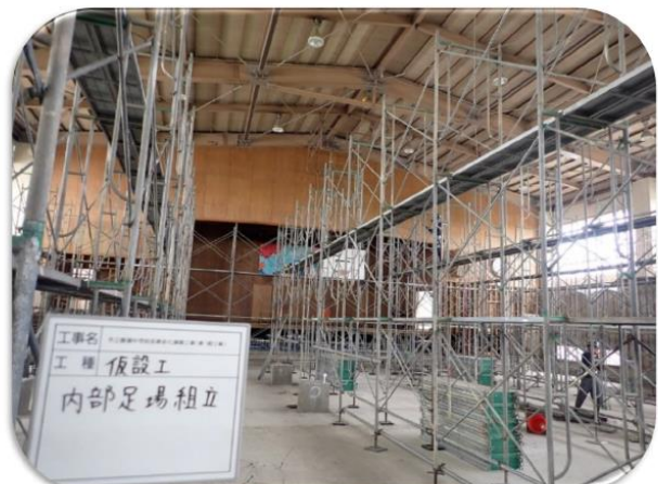
改修の準備 足場組立
