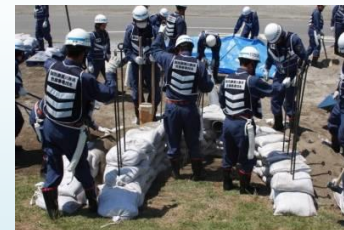
漏水防止工法『月の輪工法』 H24利根川水系連合水防演習
